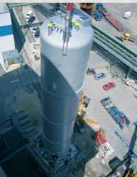
Das 30 m hohe Silo ist auf Sartorius Wägezellen aufgestellt, um Siliziumpulver in höchstmöglicher Genauigkeit zu verwiegen.
