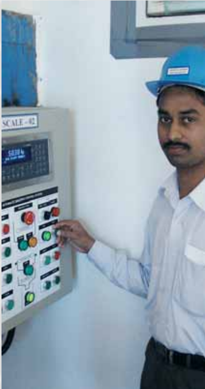
Der X5 Controller ist in einem separaten Kontrollraum in einen Schaltschrank integriert.
