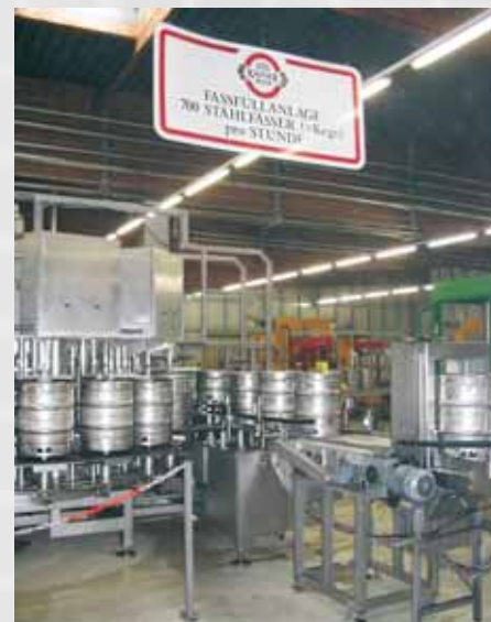
Einblick in die Gesamtanlage zur Bierabfüllung der Brauerei Wieselburg.
